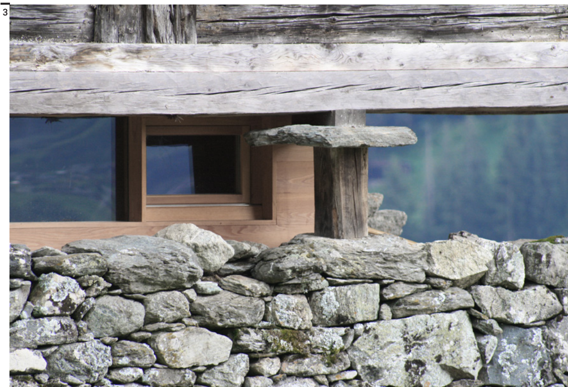
Fig. 3 Rapin Saiz Architectes, Raccard de montagne, Sarreyer, Svizzera, dettaglio (foto Rapin Saiz Architectes).
