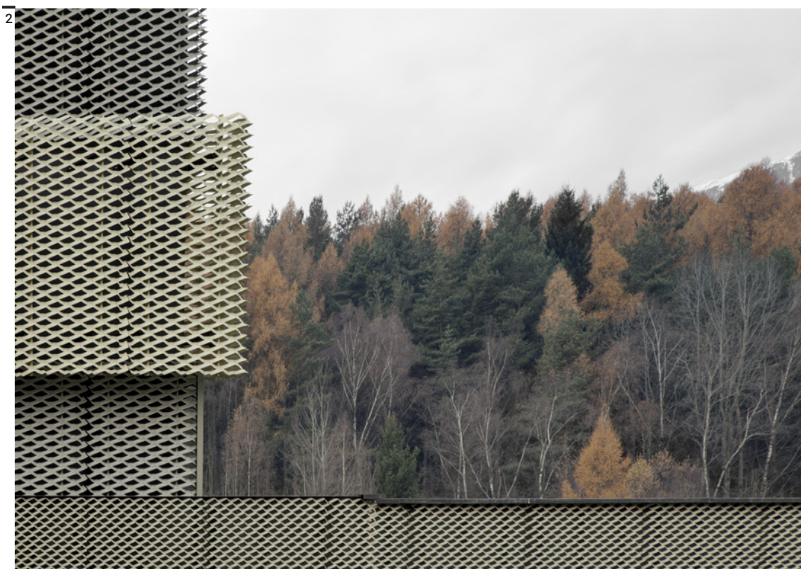
Fig. 1 Stazione travaso rifiuti, Brunico, Alto Adige, Comfort Architecten, 2015 (foto Gustav Willeit).
