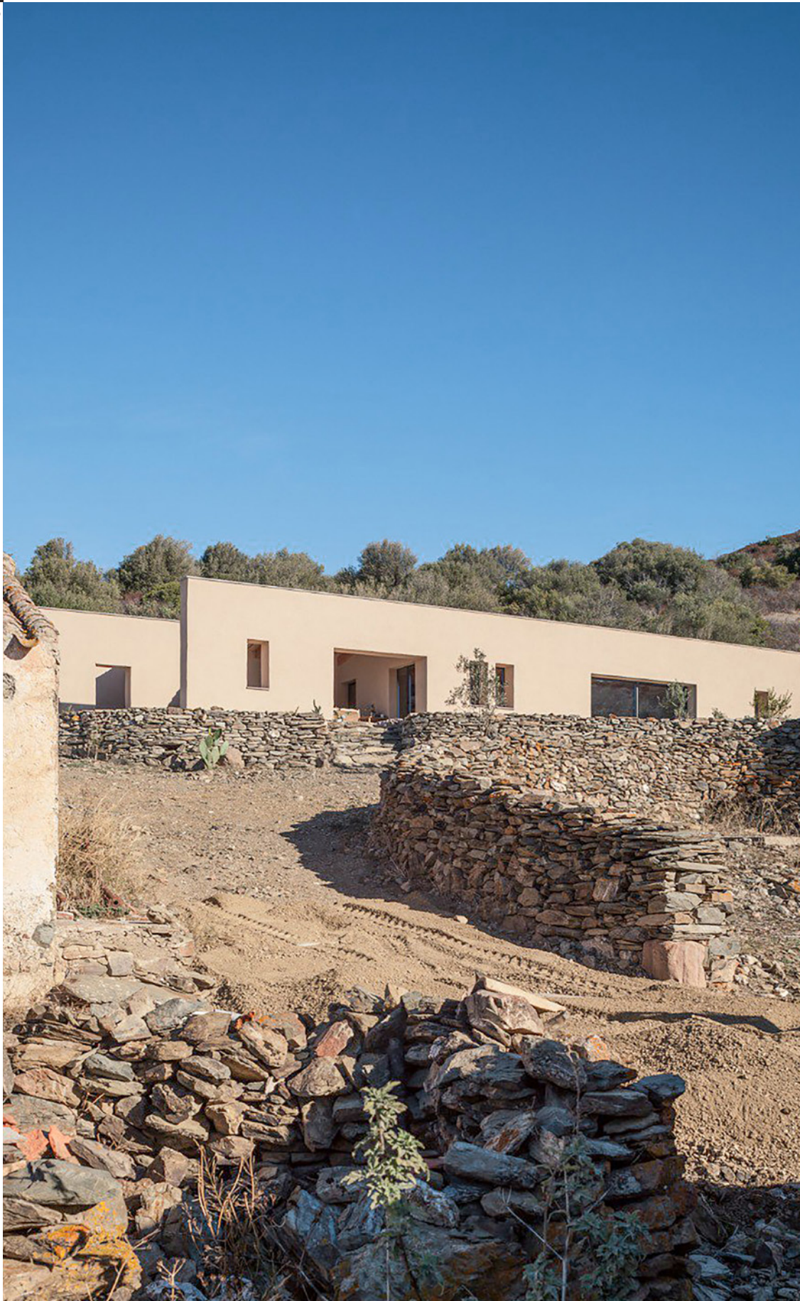
Fig. 6 Pretziada Headquarters. Il progetto prevede la riqualificazione di tre edifici rurali, con l'aggiunta di un nuovo volume nel furriadroxiu (casa- fattoria) di Is Aresus, M. Casciu, F. Rango, 2015-2017, Santadi, Sud Sardegna (foto S. Ferrando, Studio Vetro Blu).
