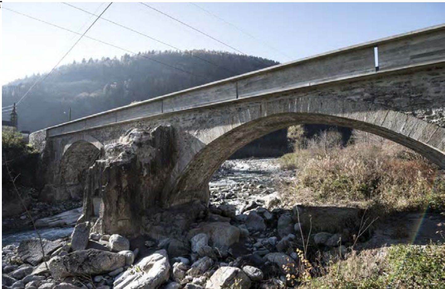
Fig. 14 Il nuovo parapetto in calcestruzzo è ritmato dalle aperture per lo scolo dell'acqua.
